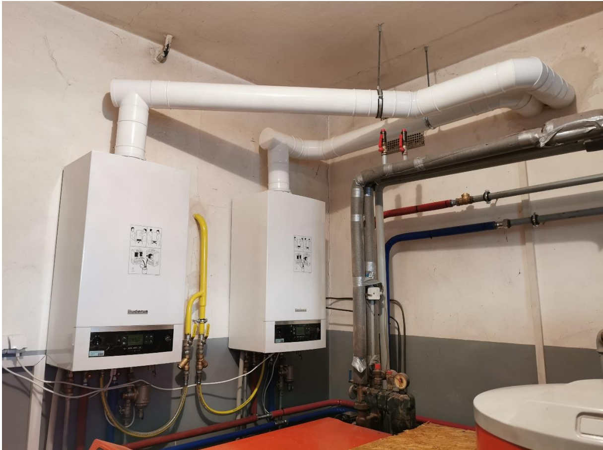
Zdjęcie 14 Budowa wewnętrznej instalacji gazowej wraz z doziemną częścią do budynku mieszkalno-usługowego m. Ratoszyn Drugi
