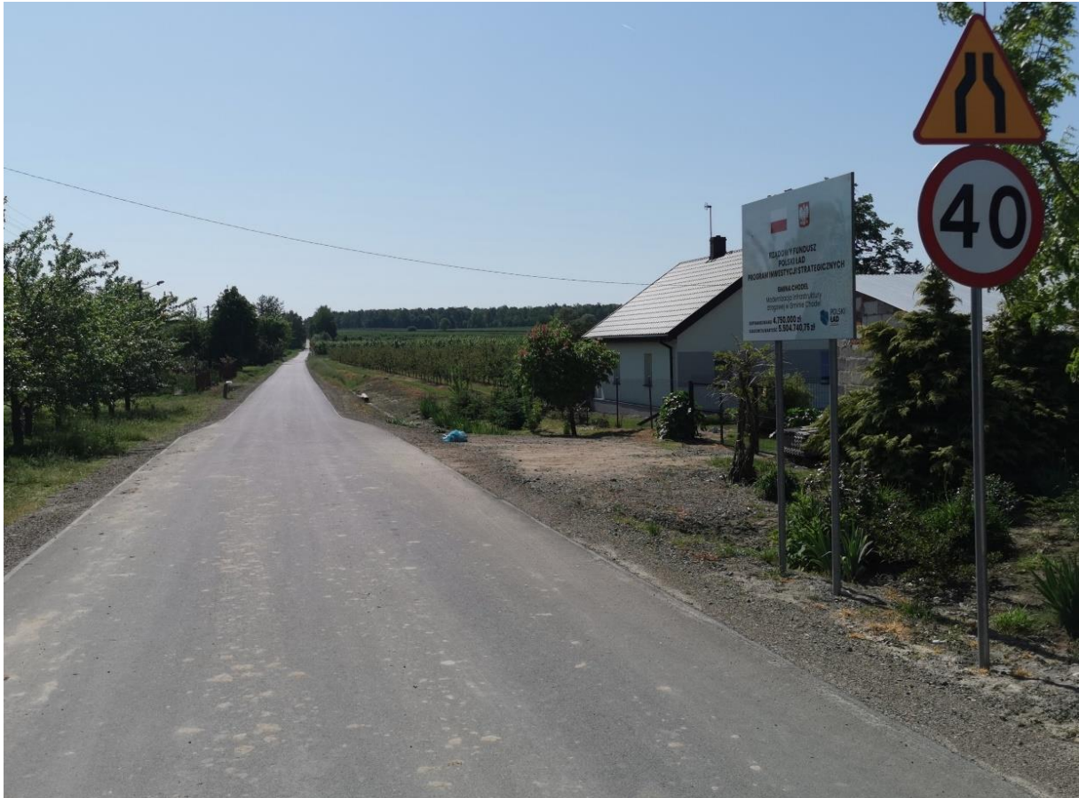
Zdjęcie 5 Modernizacja (przebudowa) drogi gminnej nr 108278L w Świdnie
