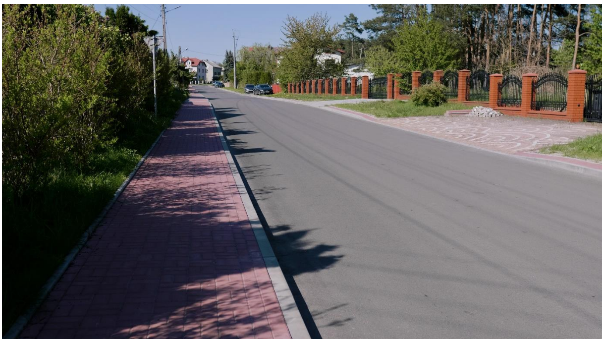
Zdjęcie 6 Modernizacja (przebudowa) drogi gminnej nr 128022L w Chodlu (ul. Piaskowa i ul. Ściegiennego)
