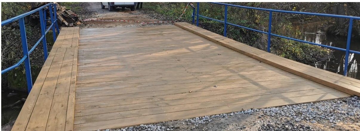
Zdjęcie 16 Wykonanie modernizacji mostu w m. Majdan Borowski
