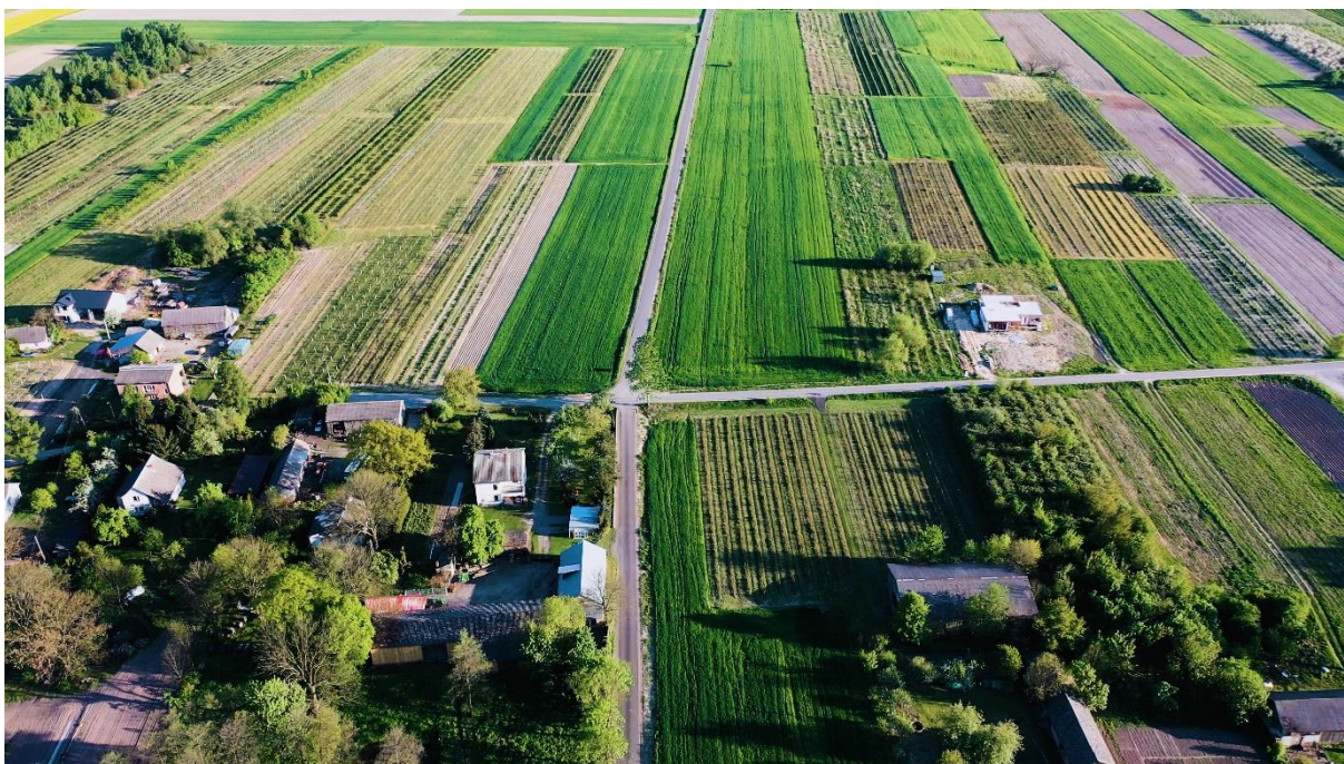
Zdjęcie 2 Modernizacja (przebudowa) drogi gminnej nr 108251L w m. Godów
