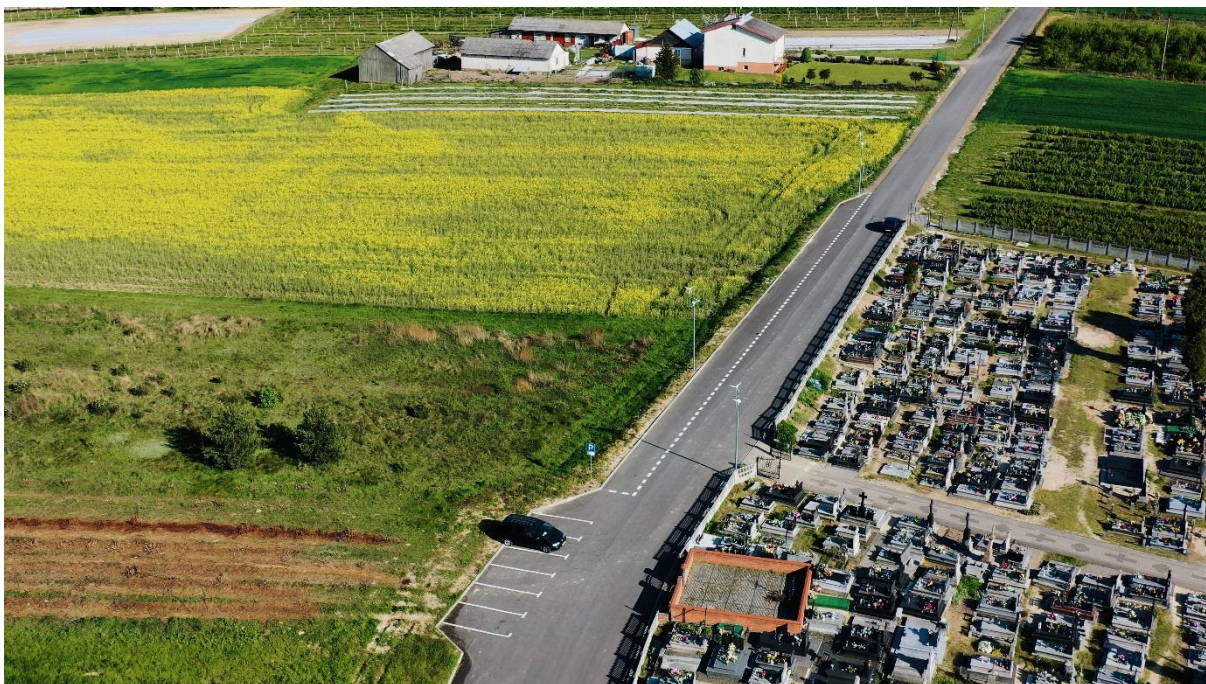
Zdjęcie 7 Modernizacja (przebudowa) drogi gminnej Nr 108244 L w Ratoszynie Pierwszym
