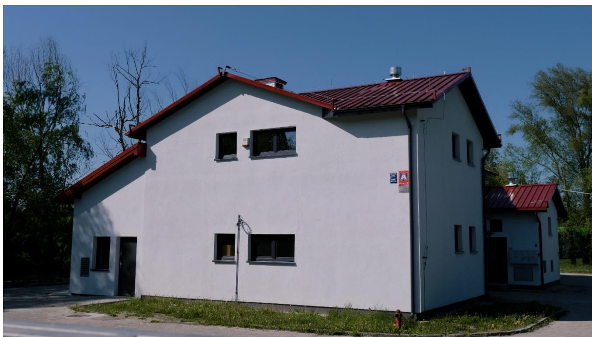
Zdjęcie 19 Rozbudowa oraz przebudowa oczyszczalni ścieków
