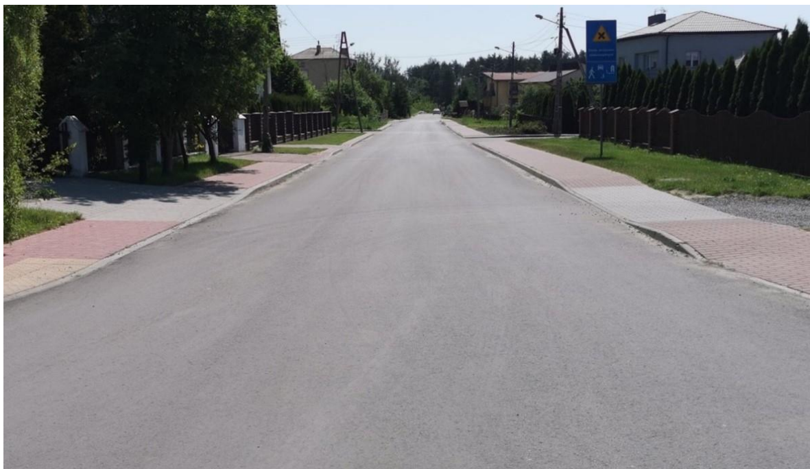
Zdjęcie 18 Remont ul. Ściegiennego (wraz z ul. Piaskową)
