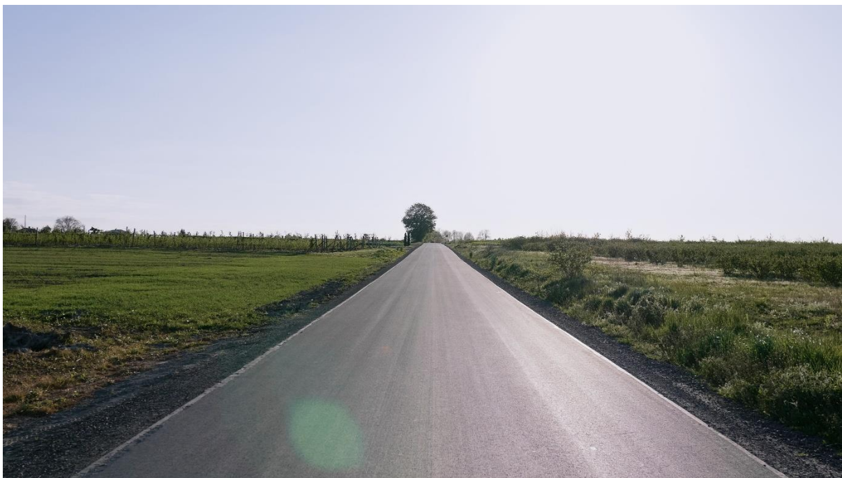
Zdjęcie 3 Modernizacja (przebudowa) drogi gminnej nr 108256L w m. Granice
