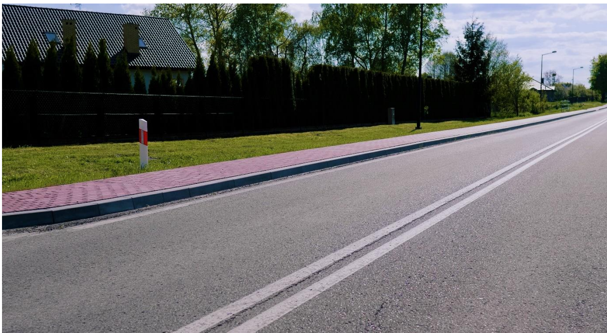
Zdjęcie 10 Budowa chodnika w m. Przytyki
